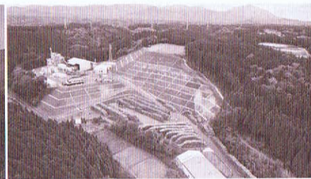
【木質バイオマス発電所】
